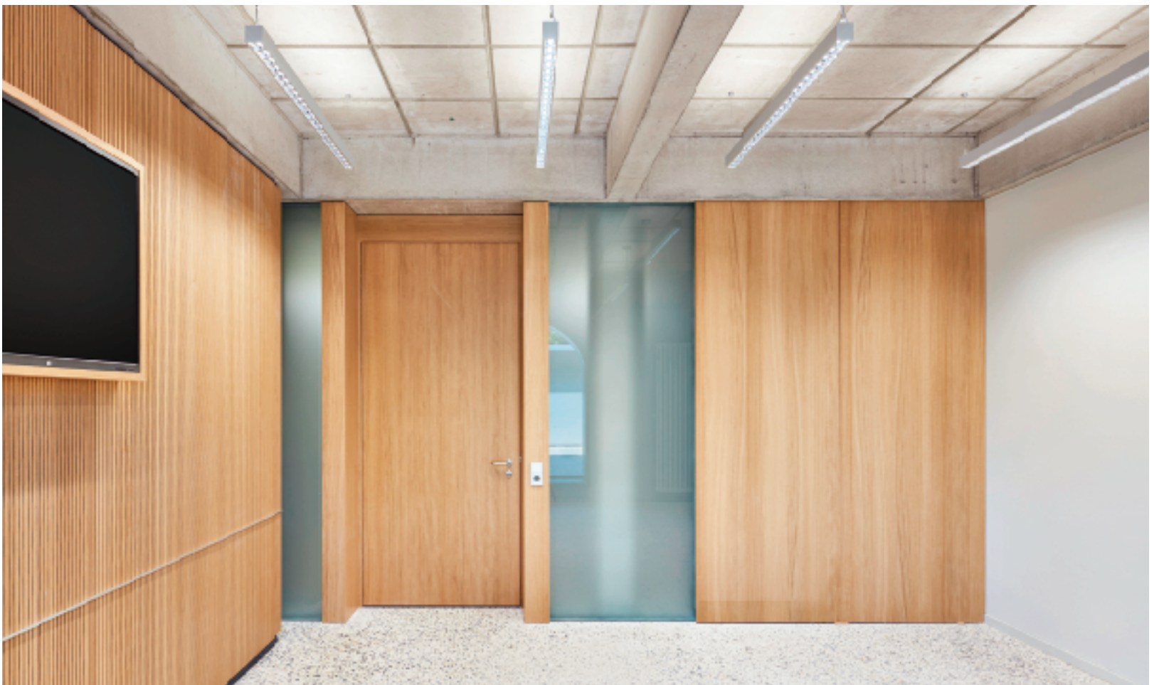
Die neue Stahlbetondecke bleibt in den Besprechungsräumen und Gerichtssälen als Konstruktion sichtbar. • The new reinforced concrete ceiling remains as a visible structure in the meeting rooms and courtrooms.
